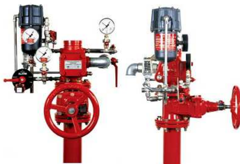
Рисунок 7. Зовнішній вигляд вузла керування TAV-T TMX/FL
